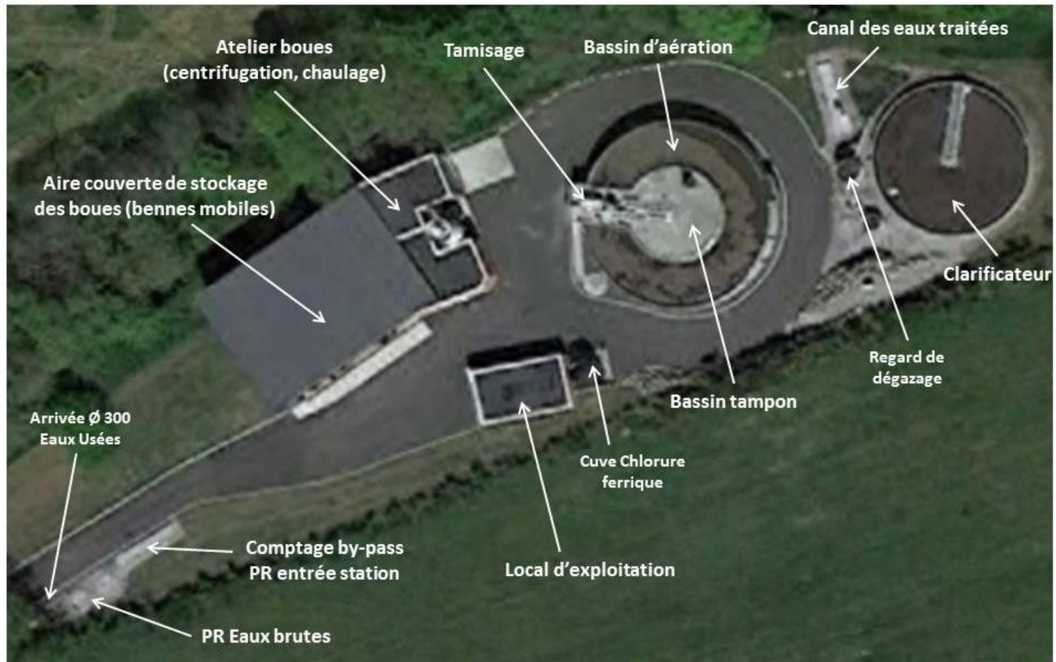
Fig. 23. Photo aérienne de la station d'épuration
