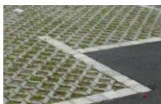
Dalle alvéolaire (béton) - Source : Even Conseil
