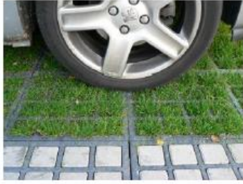
Dalle alvéolaire (béton ou plastique) - Source : Sol-aire
