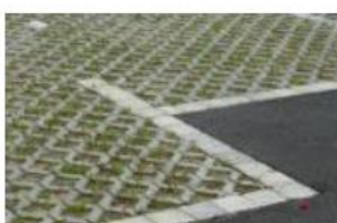
Dalle alvéolaire (béton) - Source : Even Conseil
