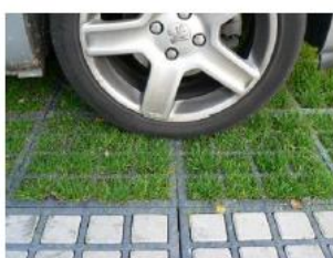
Dalle alvéolaire (béton ou plastique) - Source : Sol-aire
