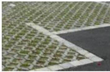
Dalle alvéolaire (béton) - Source : Even Conseil
