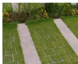
Solution mixte dalles alvéolaire/ pavés Source : Sol-aire
