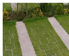
Solution mixte dalles alvéolaire/ pavés Source : Sol-aire
