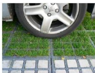
Dalle alvéolaire (béton ou plastique) - Source : Sol-aire
