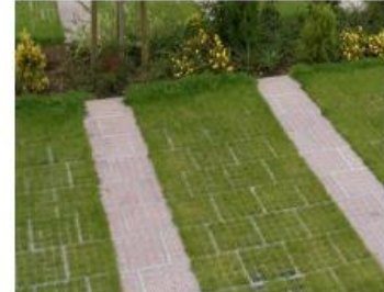
Solution mixte dalles alvéolaire/ pavés Source : Sol-aire
